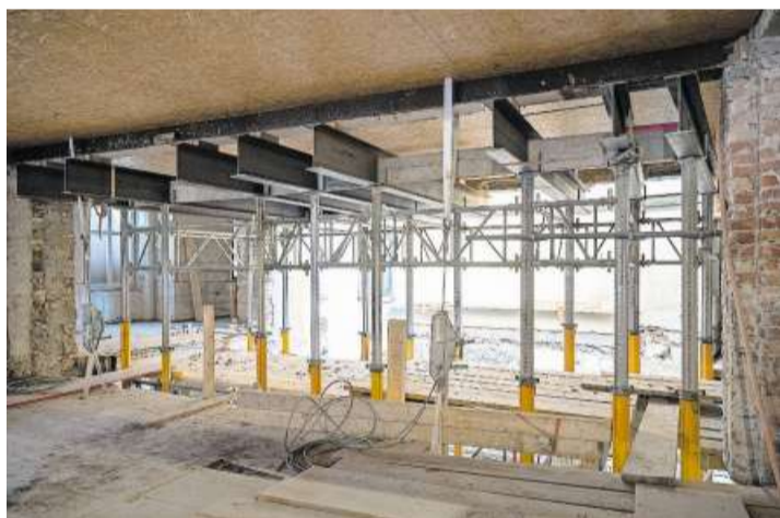
Im «Bären» sorgen Stahlträger für Stabilität. Bild: Alex Spichale
